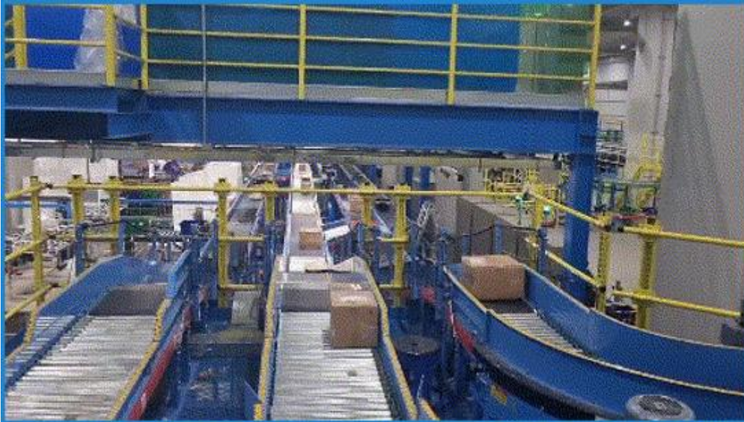
물류 센터 Conveyor
